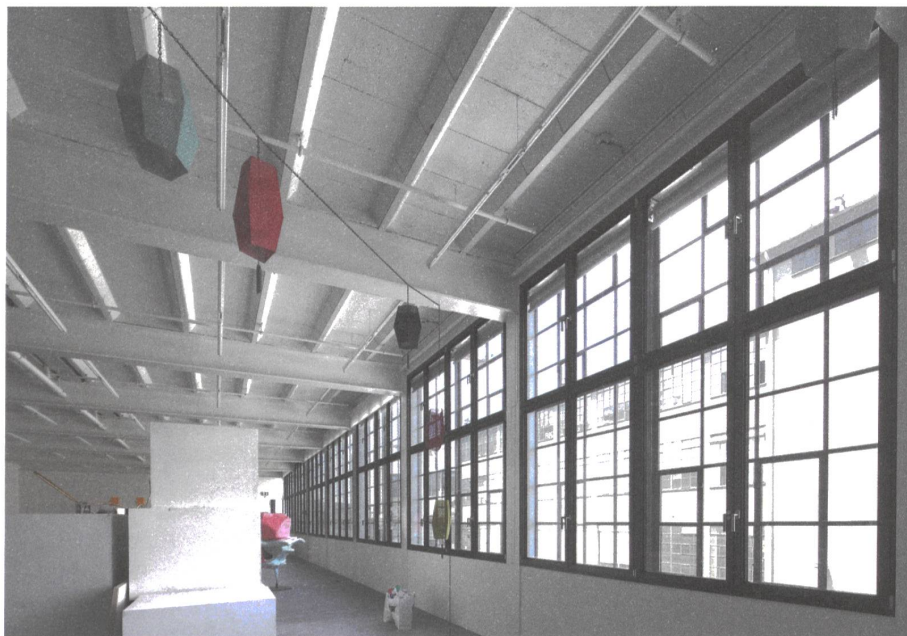
Eine von innen aufgedoppelte Metallfensterschicht ermöglichte die neue Nutzung der alten Maag-Halle in Zürich.
