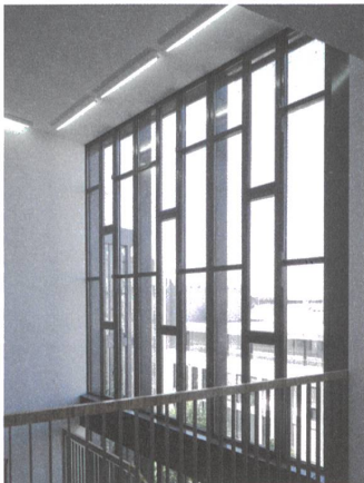
Gitterartige Glasfassade: Die Einteilung verleiht den Räumen etwas Privatsphäre.
