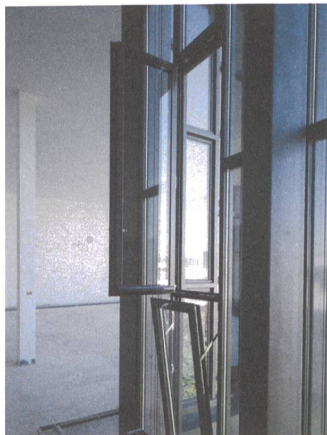
Oben Dreh-, unten Kippflügel: Der mittlere Fensterstreifen lässt sich öffnen.
