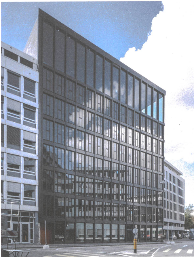
Tektonische Architektur: Knoten, Relief und Muster des Bürohauses werden zum Zierstück des Picassoplatzes in Basel.
