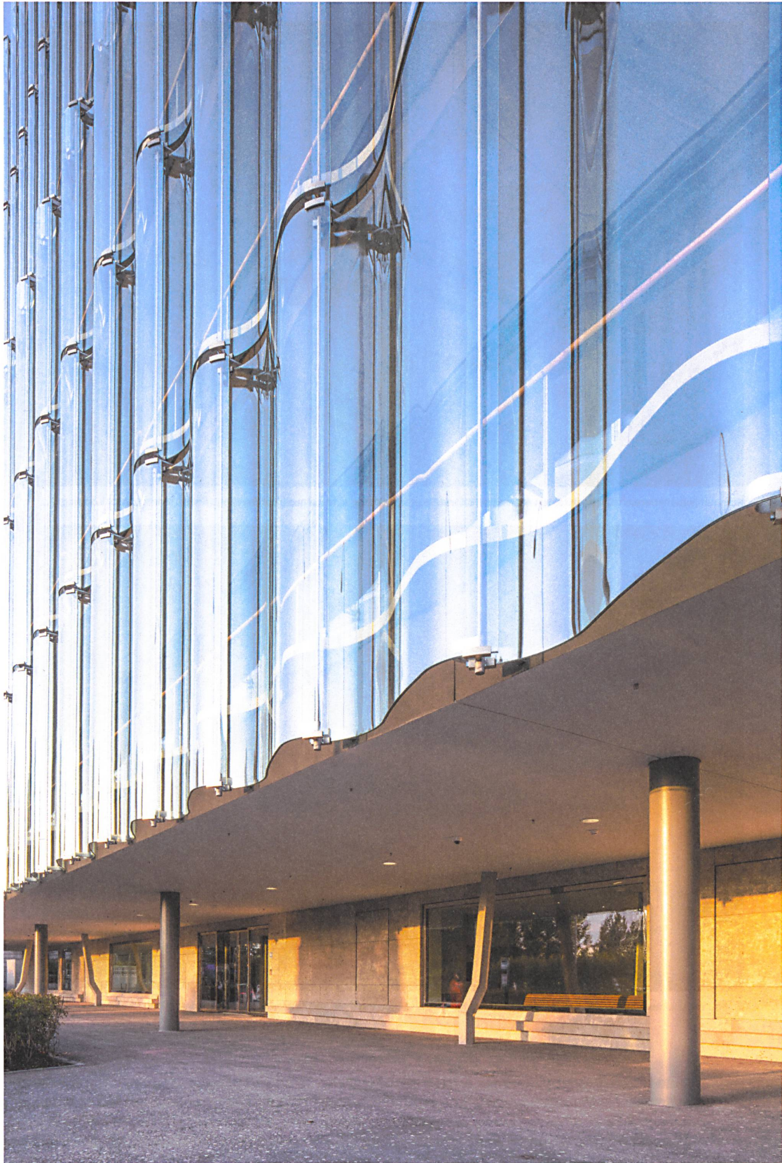
Fast zweieinhalb Meter hoch, mehr als eine halbe Tonne schwer und technisch überflüssig: die Glaswellen der Fassade. Die geknickten Stützen gehören zur Lobbygestaltung des Künstlers Martin Boyce.
