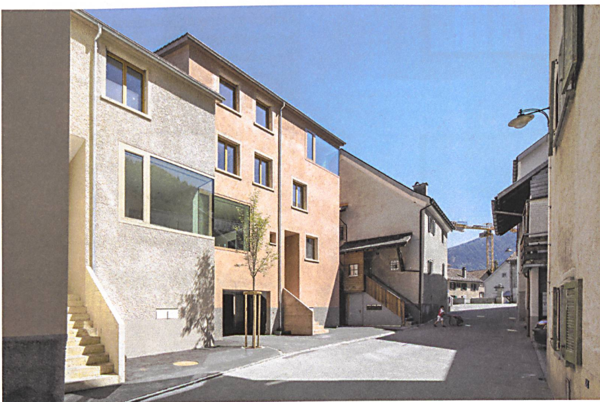
Treppen, Kännel, Vor- und Rücksprünge helfen, die stattlichen neuen Häuser in Haldenstein den alten anzugleichen.
