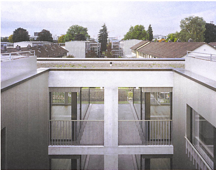
Wohnsiedlung Riedgraben in Zürich Nord: Ein Lichtthof, der den Blick auf die Siedlung am Burriweg offen lässt.
