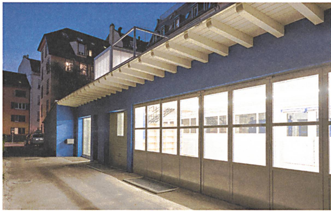
Zum Grafikatelier umgebaute Garage in Zürich: Blick durch die Falttore ins Innere.
