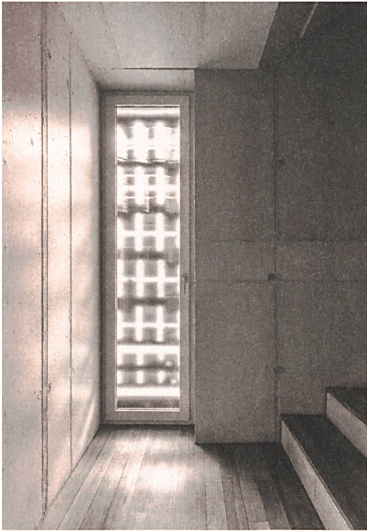
Im Treppenhaus sieht man schemenhaft die Technik in der Fassade. Der Holzboden stammt vom Abbruchhaus.
