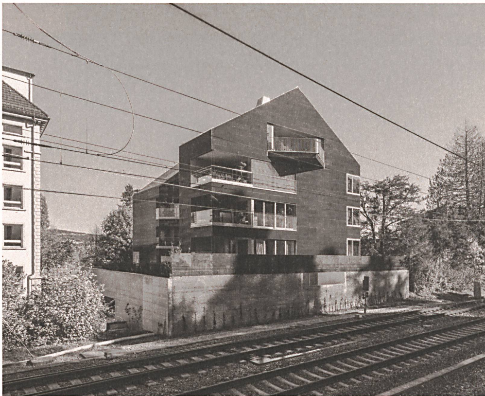
Der eine Teil des Hauses erhebt sich leicht gegenüber dem anderen. Die Sockelmauer zur Bahn soll zuwachsen.
