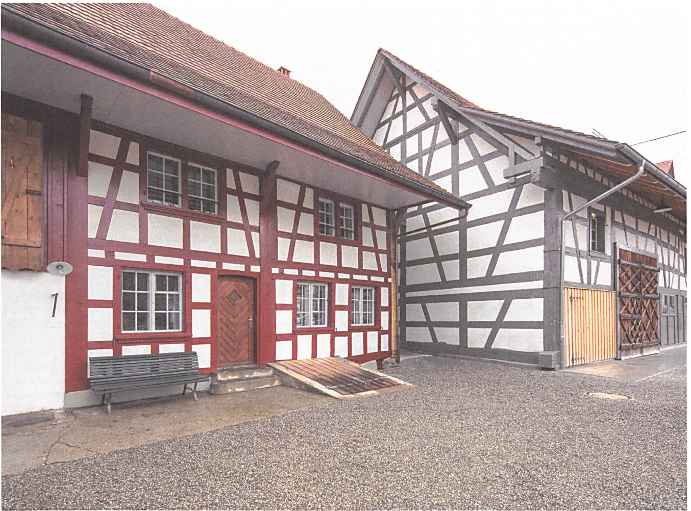
Das Haus Wyttenbach mit den neuen Gästezimmern ist der älteste Bau des Ensembles. In der Scheune (rechts) ist Platz für eine Wäscherei und Personalgarderoben.
