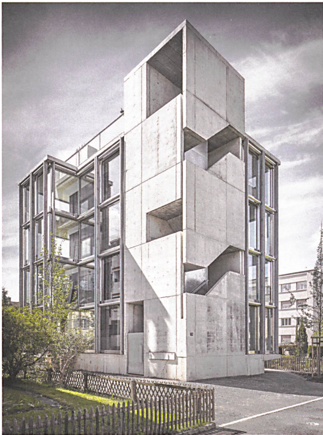
Glashaus mit Betonturm: loftiges Wohnen in Winterthur.
