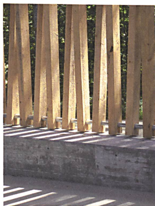
Die schiefen Fassadenhölzer stehen auf einem Metallrohr.
