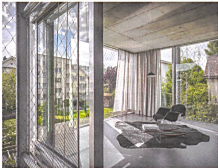
Jedes zweite Fenster lässt sich raumhoch aufschieben.
