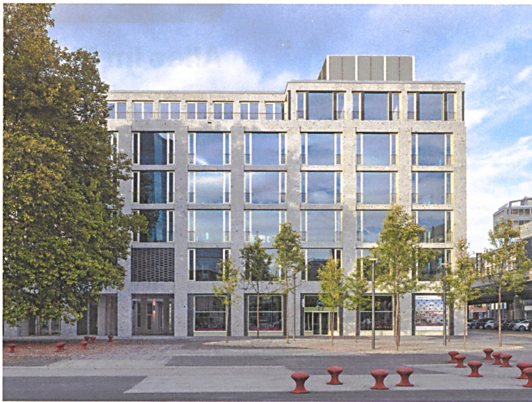
Das Bürogebäude in Zürich-West schliesst den Schiffbauplatz elegant ab.
