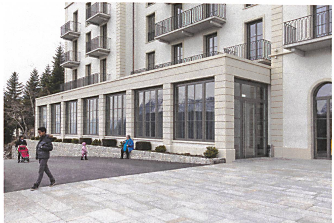
Die Details am Sockel des Palace-Hotels auf dem Bürgenstock sind kaum sorgfältiger ausgeführt, als es am Hang von Ennetbürgen der Fall wäre.
