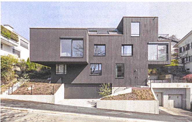
Das Mehrfamilienhaus in Zürich-Engel ist mit vertikal verlegten, dunkel gestrichenen Holzlaten verkleidet.
