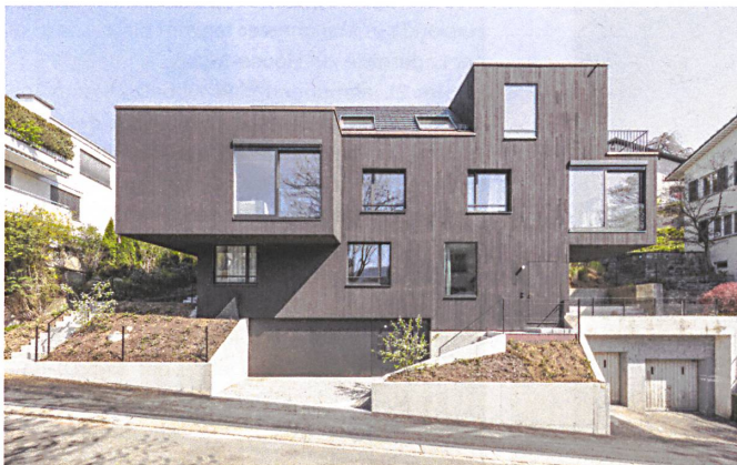
Das Mehrfamilienhaus in Zürich-Enge ist mit vertikal verlegten, dunkel gestrichenen Holzlatten verkleidet.
