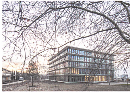
Der Neubau auf dem Campus der Universität Lausanne gibt sein reiches Inneres nach aussen nicht preis.
