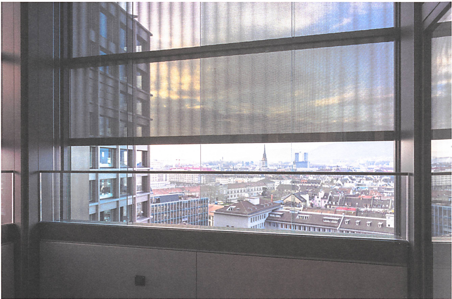
Von innen wirkt das perforierte Wellblech wie ein Textil. | De l'intérieur, la tôle ondulée perforée a un effet de textile.
