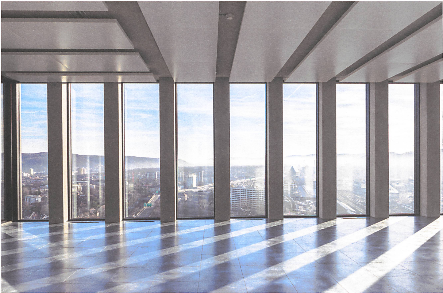
Fassadenpfeiler und Decke zeigen die ungeschminkte Tragstruktur. | Les piliers de la façade et le plafond montrent la structure porteuse à l'état brut.
