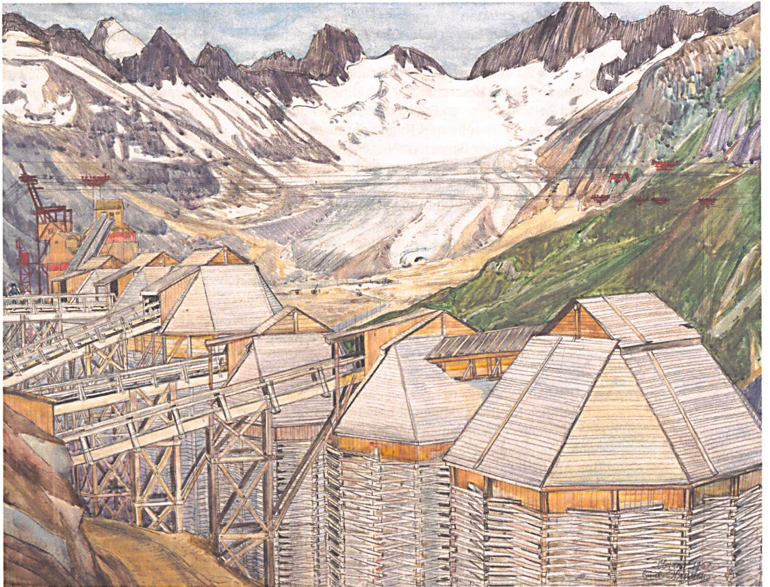
Holzverschalte Johnson-Türme für die industrielle Zementaufbereitung. Staumauer Oberaar. Tempera, Kreide und Bleistift auf Papier, 1952.
