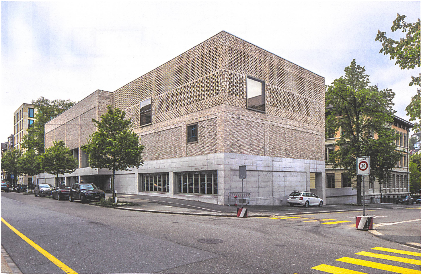
Der Ersatzneubau bestimmt den Strassenraum mit einer kräftigen Klinkerfassade, die Turnhalle und Sportplatz umhüllt.
