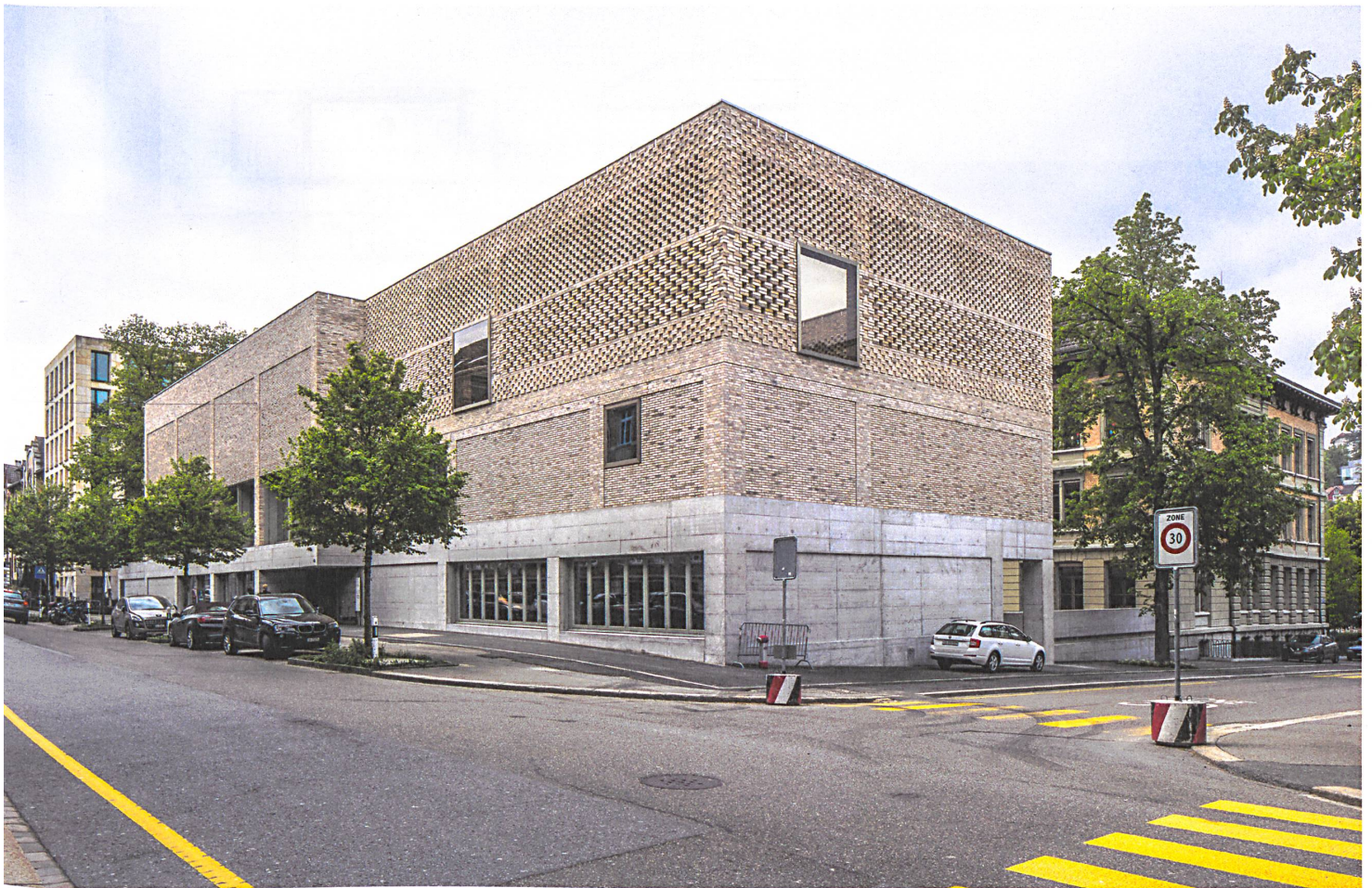
Der Ersatzneubau bestimmt den Strassenraum mit einer kräftigen Klinkerfassade, die Turnhalle und Sportplatz umhüllt.
