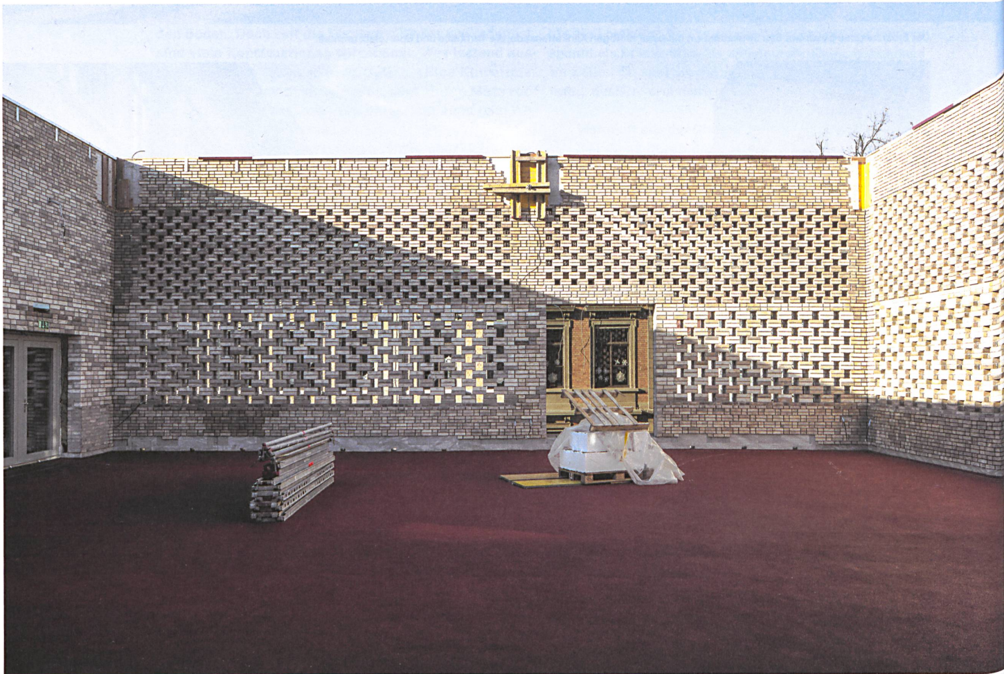
Auf dem Sportplatz auf dem Dach des Neubaus spielen die Kinder bald Basketball.
