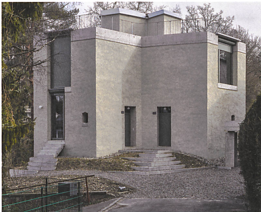
Die beiden Köpfe an der Zufahrt des Wohnhauses an der Lerchenstrasse in Basel.
