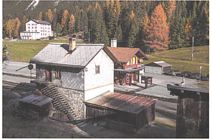
Das nicht mehr gebrauchte Lüftungshaus bei Preda wird als Zeuge der Albulabahn wiederhergestellt und erhalten. Foto: Max Galli
