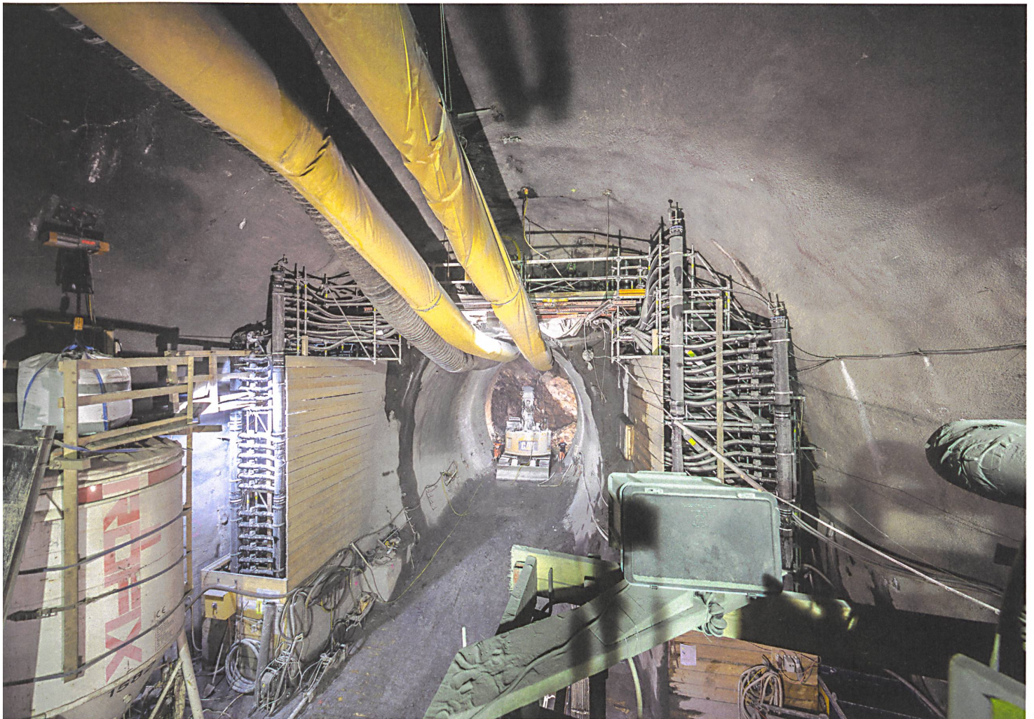
Noch ist der neue Albulatunnel nicht durchgängig. Im Sommer 2018 beginnt der Innenausbau. Foto: Andrea Badrutt
