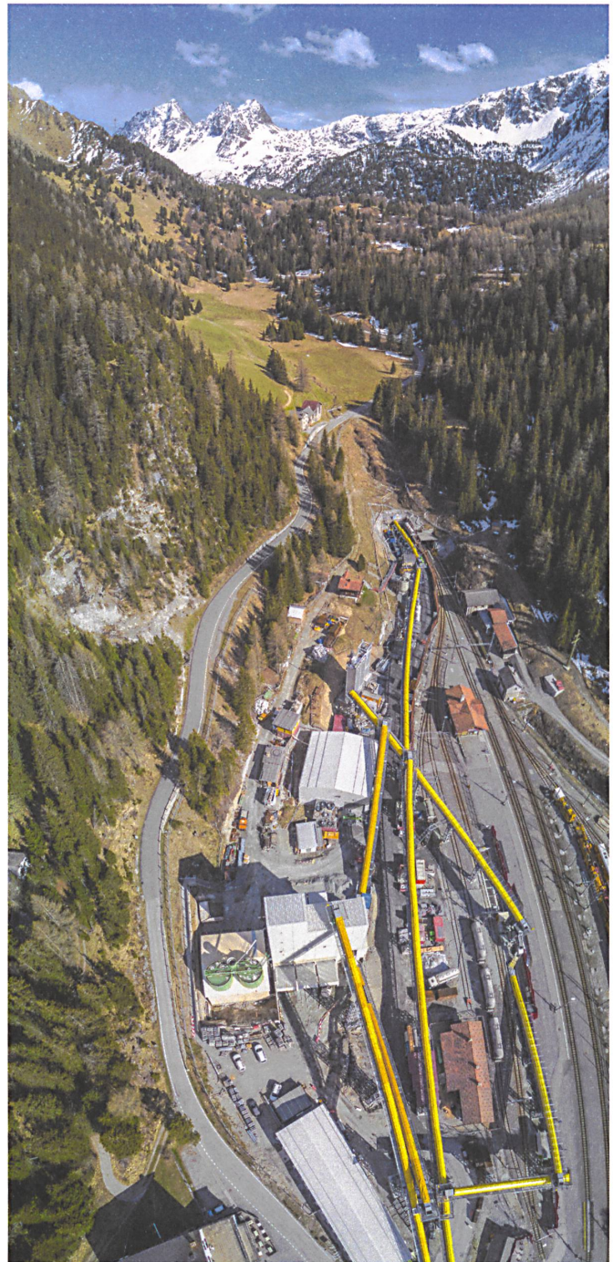
Ein Industriewerkplatz im Gebirge: die Baustelleninstallation bei Preda für den Albulatunnel. Foto: Patrick Cavelli
