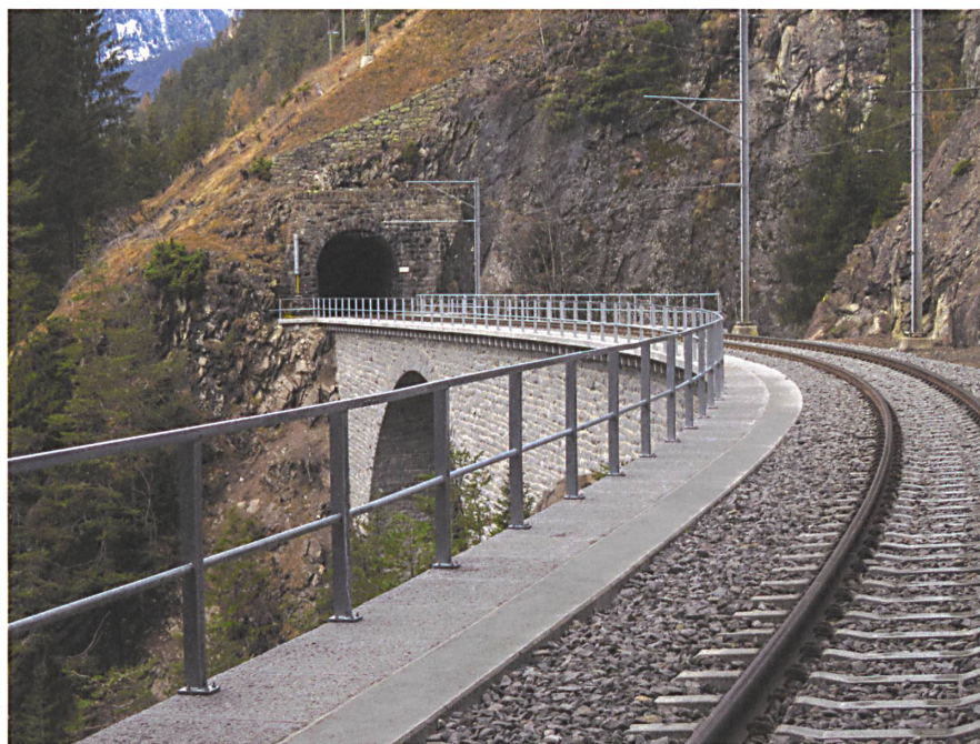
Der Kragen aus Stein, der Trog für die Fahrbahn aus Beton.
