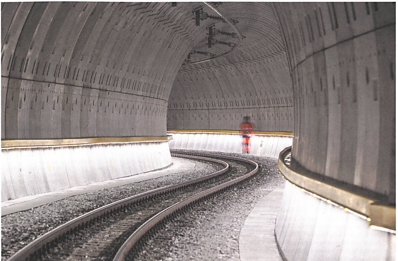
In eleganter Schlinge fährt der Zug durch den Gletscheras-Tunnel, ausgekleidet mit mehr als 1500 Betonelementen.
