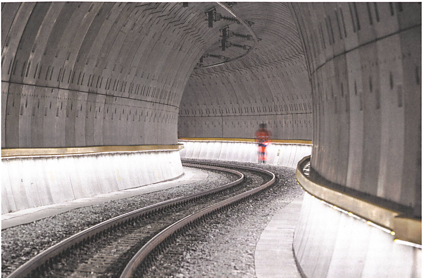
In eleganter Schlinge fährt der Zug durch den Glatscheras-Tunnel, ausgekleidet mit mehr als 1500 Betonelementen.
