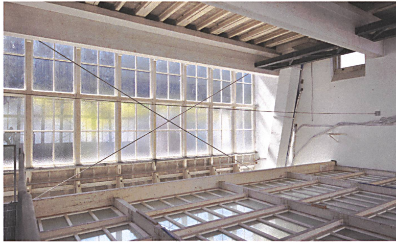
Das Interieur der Laterne, die Tageslicht ins Haus holt und in der Nacht nach aussen leuchtet.
