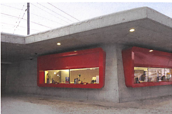
Die neue Unterführung zur Jakobshorn-Bahn.
