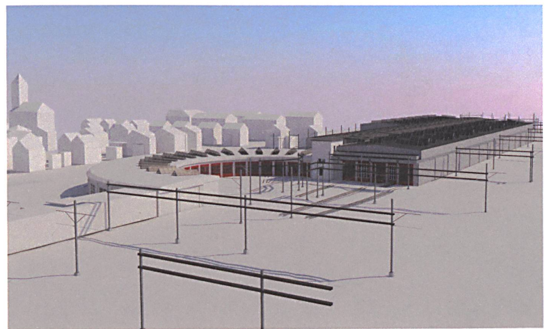
Drehscheibe, Depot und Hauptwerkstatt werden zur neuen Adresse in Landquart.
