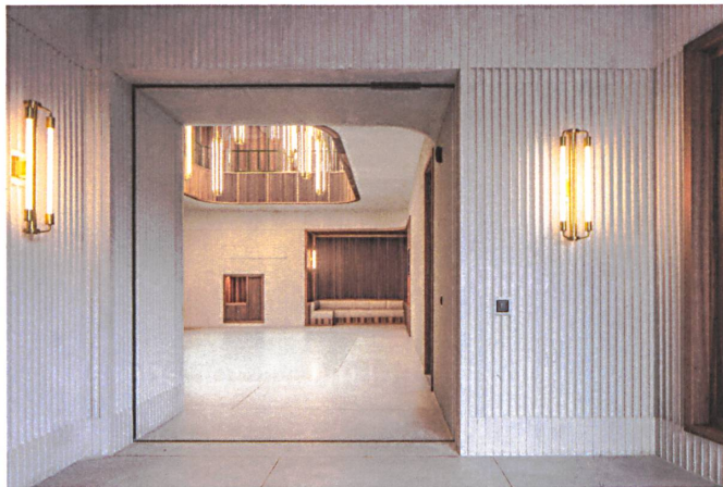
In die geschliffenen Sichtbetonwände sind die Holzausbauten wie Intarsien eingelassen.
