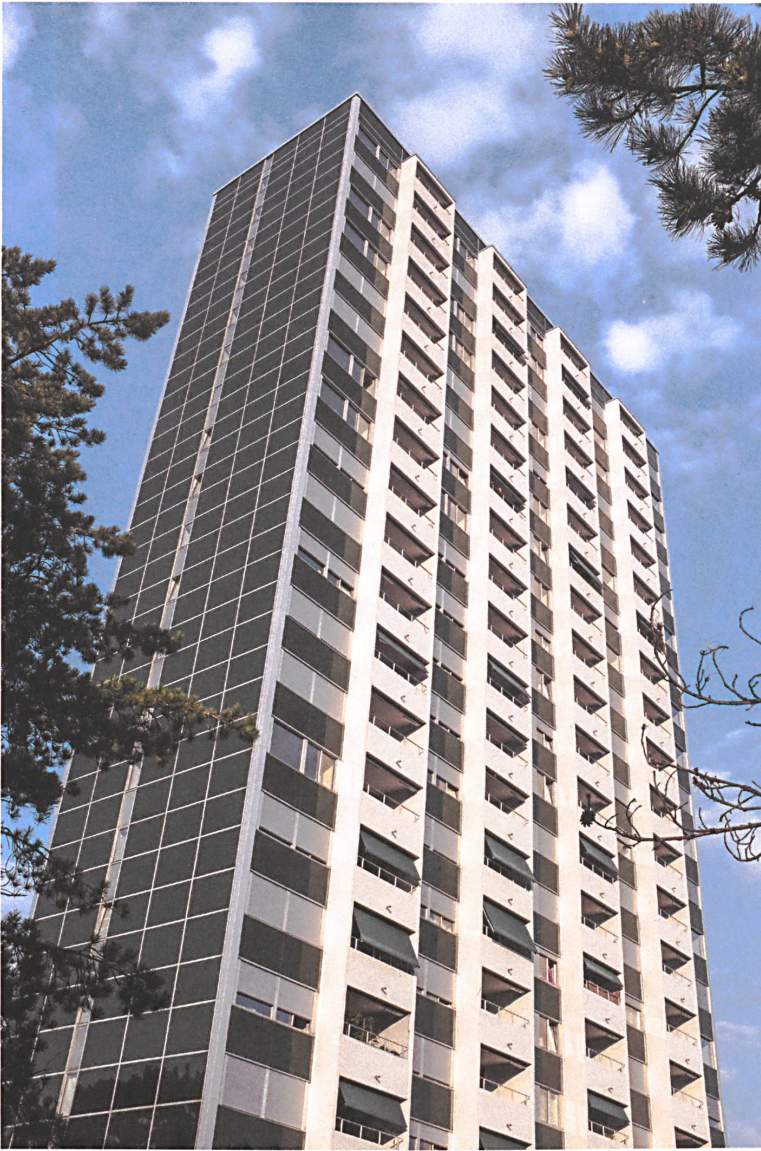
Optisch unmerklich ist die Fassade heute dreimal energieeffizienter als vorher.
