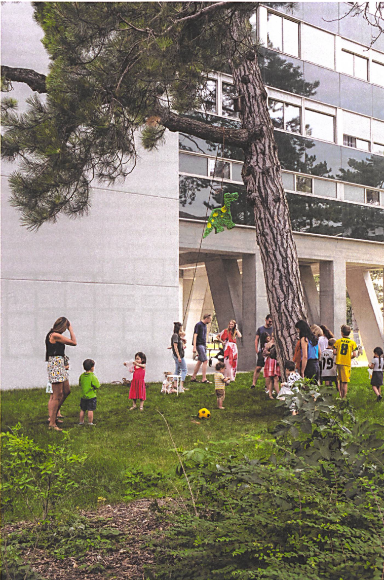
Pilotis und Bandfenster, Beton und Aluminium blieben erhalten. Die zwei Ölheizungen nicht.
