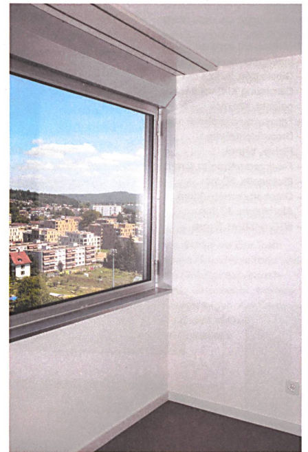
Zwischen neuen Storenkästen und Fensterbänken stecken akribisch sanierte, filigrane Alurahmen-Fenster.
