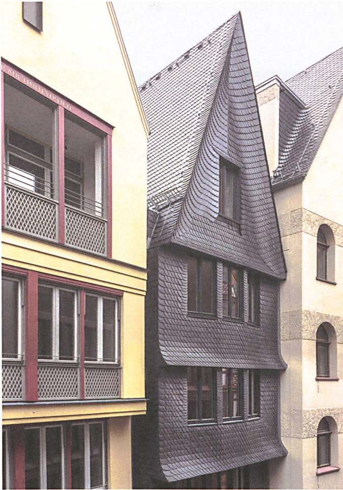
Drei «Neubauten» unterschiedlicher Qualität. Das Berliner Büro von Ey plante das mit Schiefer verkleidete Haus in der Mitte. Foto: von Ey Architekten
