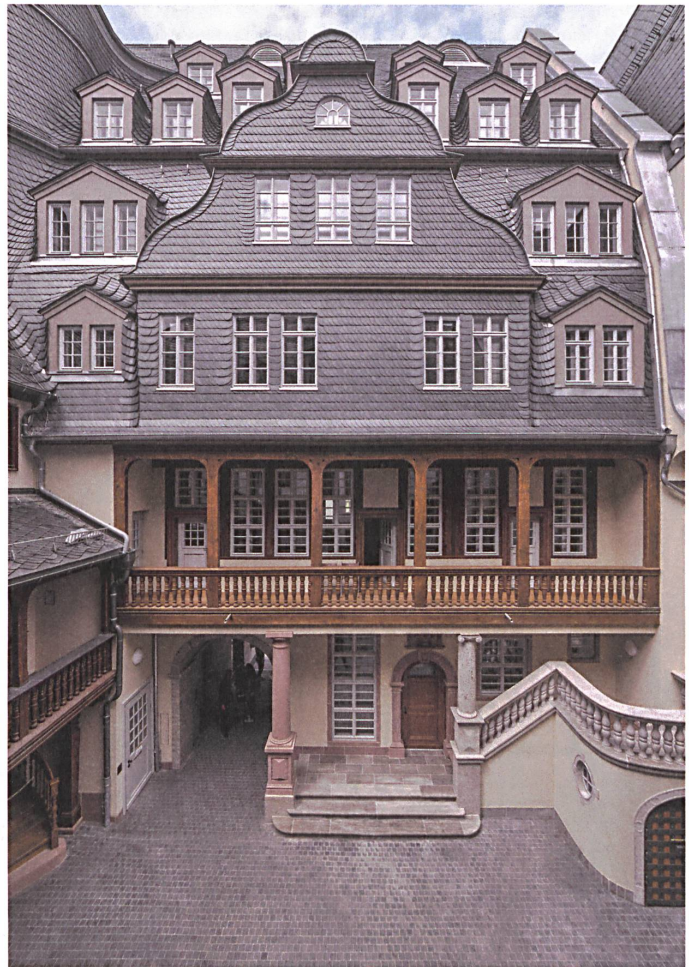
Die barocke Fassade im Lämmchenhof rekonstruierte Bernd Albers. Foto: Stefan Müller
