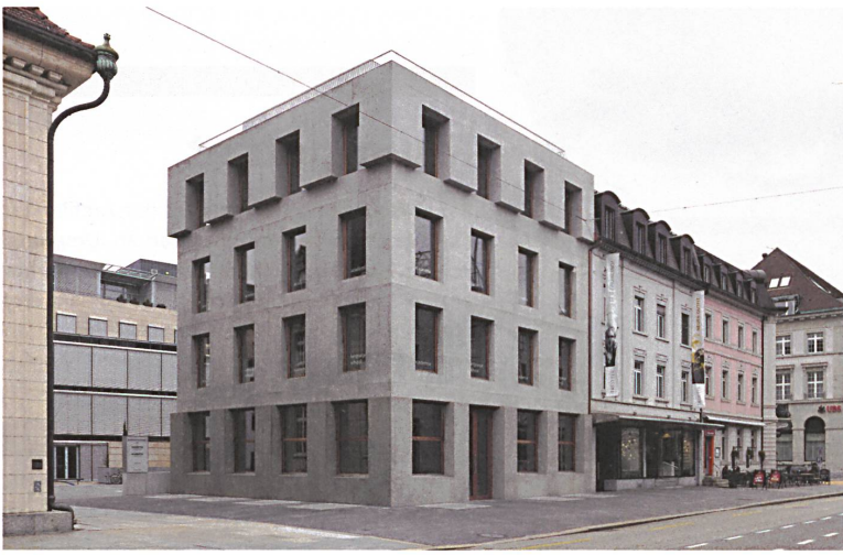
Der Sichtbetonkubus an der Bahnhofstrasse in Aarau ersetzt einen aus Stein gemauerten Altbau.
