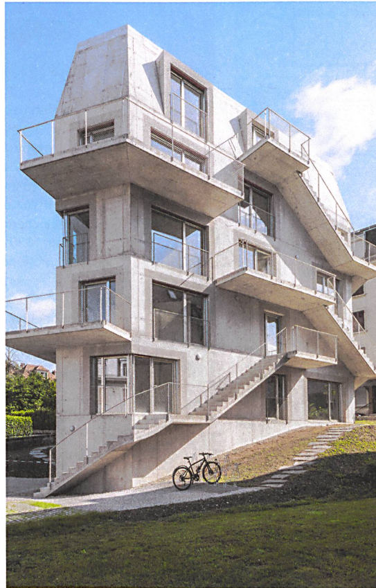
Balkone und Treppenläufe erweitern das Wohnhaus in Renens um eine zweite, luftige Raumschicht.
