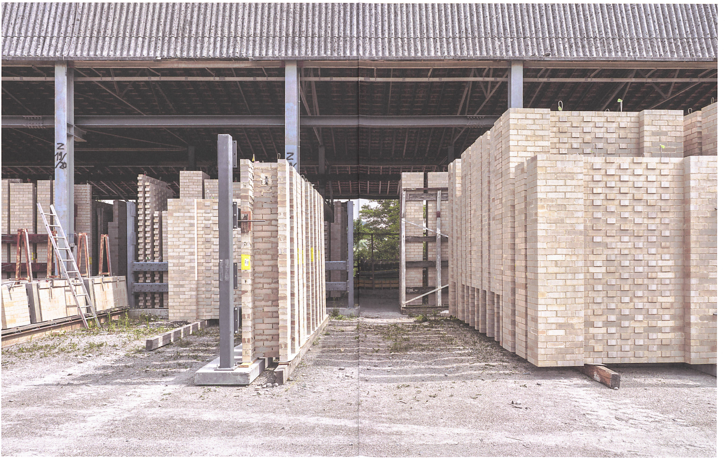
Vorgefertigte Wändelemente wiegen meist maximal sieben Tonnen, denn hier ist die Komfortgrenze des Hallenkrans und der meisten Baustellenkrane erreicht.
