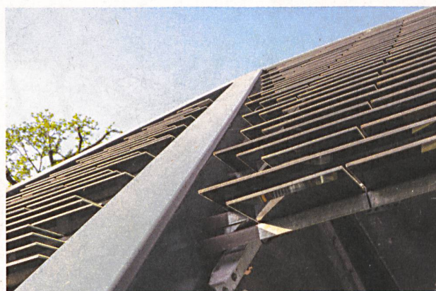
Die Module wirken wie aufgestellte Schindeln. Bewegen lassen sie sich allerdings nicht.
