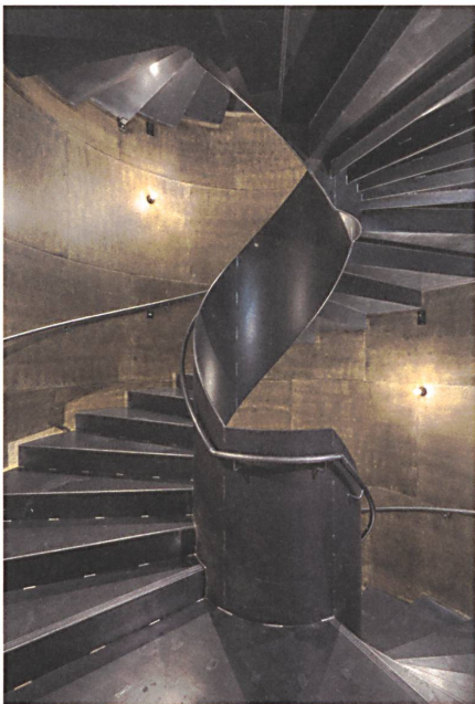
Die Haupttreppe: Der Stahl und die Wände aus Gipsfaserplatten sind geölt.
