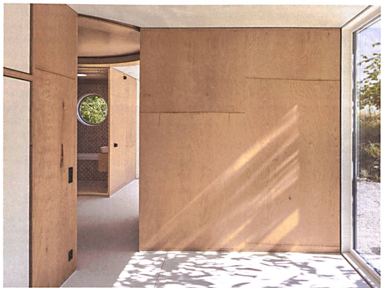
Das Möbel ist die Tragstruktur: Regale aus vier Zentimeter dünner Baubuche tragen das Dach.
