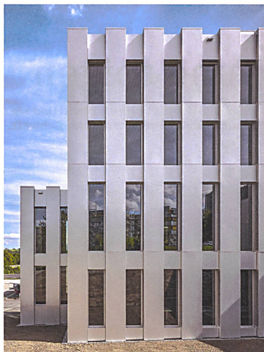
Des panneaux Alucobond revêtent la façade tout en rigueur.
