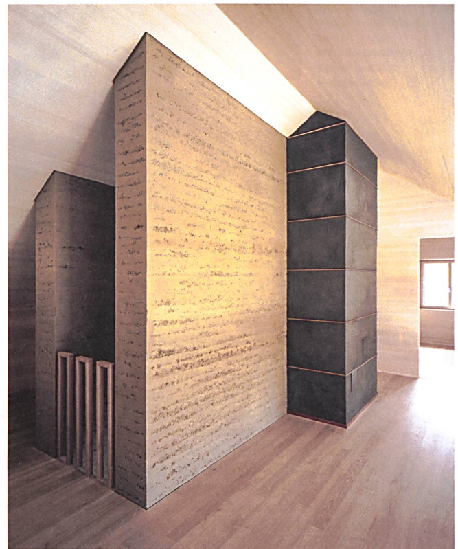
Zwei Stampflehmwauern regulieren die Luftfeuchtigkeit und speichern die Wärme des Stückholzofens.
