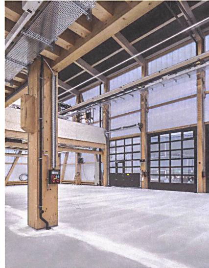
Die Architektur rückt das Tragwerk in den Mittelpunkt.
