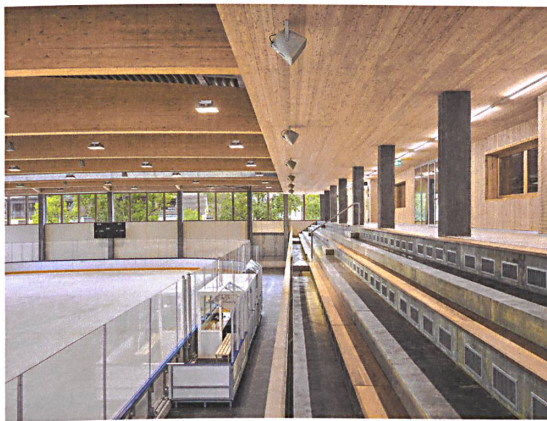
26 Das Holzdach sitzt auf Betonstützen.
