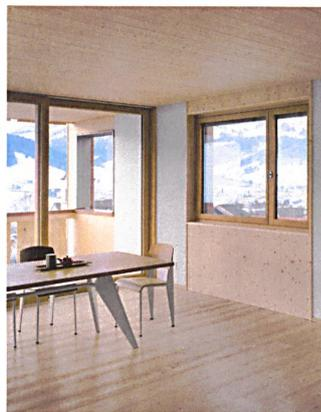
39 Die Aussenwände bestehen aus verdübeltem Massivholz.
