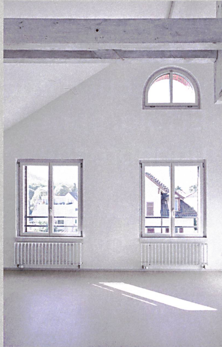
In den zwei Dachwohnungen konnten unter Einbezug des ehemaligen Estrichs überhohe Räume realisiert werden.
