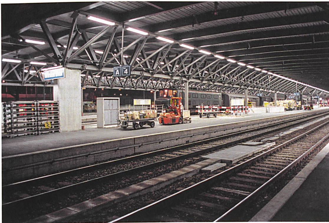
Im Dezember 1986, kaum fertig und noch ohne den vielfarbigem Anstrich, zeigte die Konstruktion eine gewisse Ästhetik – insbesondere nachts.
