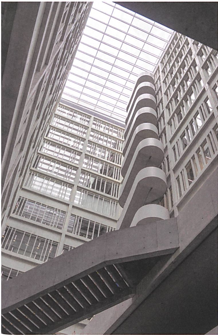
Freistehende Treppen verbinden die Geschosse in den beiden Innenhöfen.
