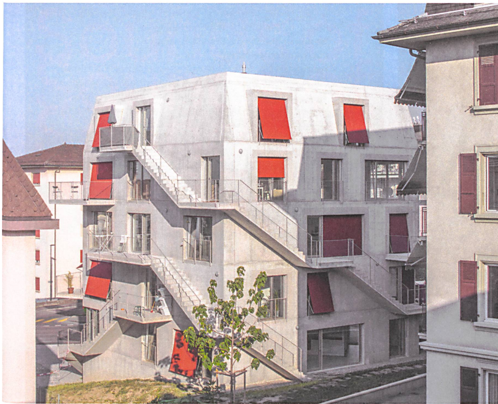
Drei aussenliegende Treppen führen zu den Wohnungen.
