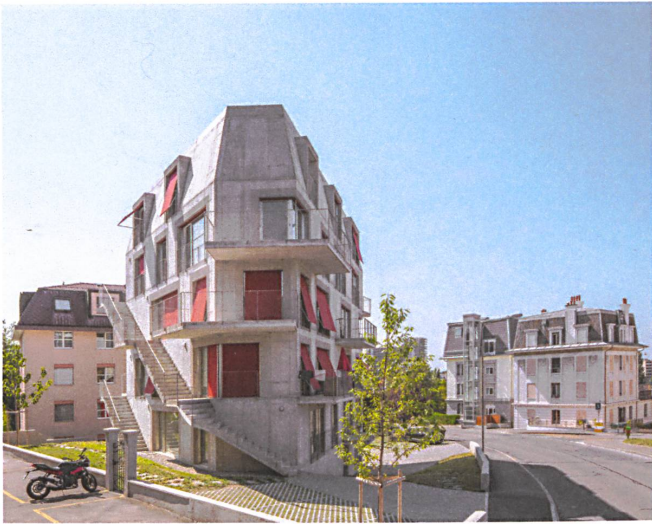
Der Neubau überträgt die Themen aus der Nachbarschaft in Sichtbeton.
