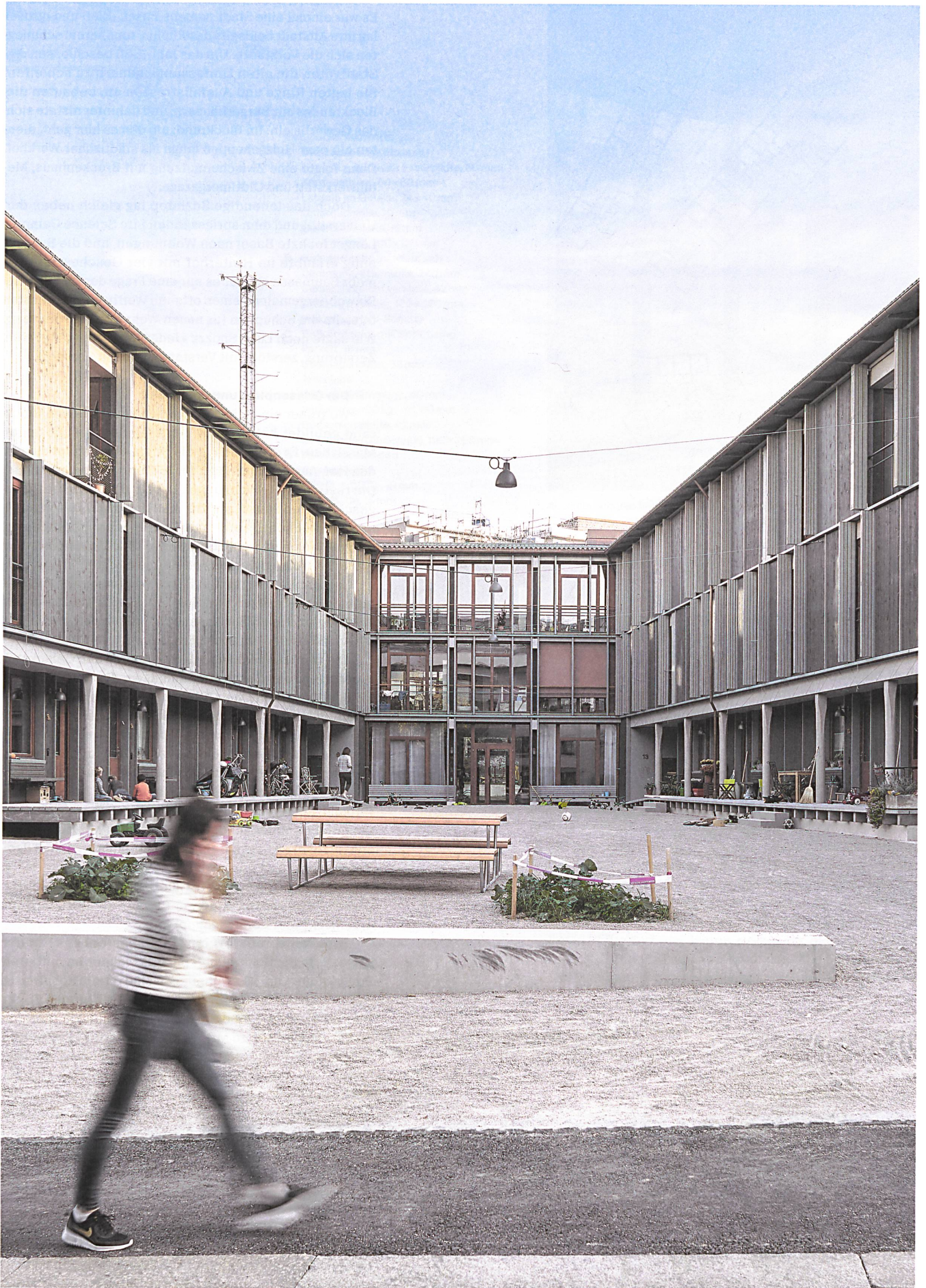
Ein Gassenplatz ist das Herz der Siedlung Maiengasse in Basel mit einem Kindergarten in der Mitte und Veranden vor den Maisonette-Wohnungen.
