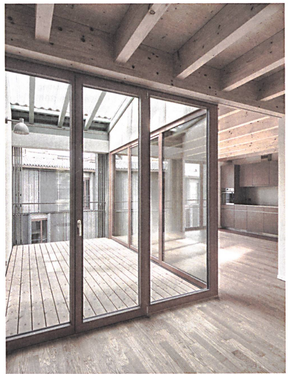
Auch die Loggien folgen dem Takt von Primär- und Sekundärträgern. Zuoberst liegt Polycarbonat statt Welleternit über den Sparren.
