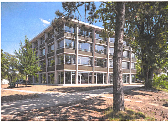
Die Fassade erinnert an die Bestandsbauten aus den Fünfzigerjahren.
