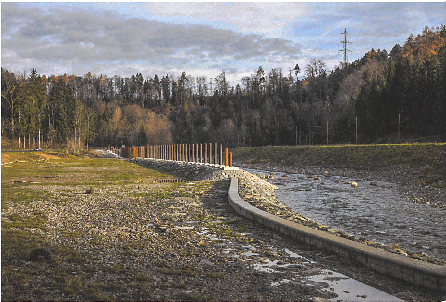
Der 350 Meter lange Schwemmholzrechen in der Sihl ist das Resultat eines landschaftsarchitektonischen Blicks auf einen Infrastrukturbau.
