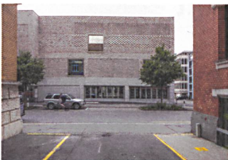
Schulhaus St. Leonhard, St. Gallen Claus Merz Architekten, Basel
