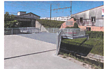
Brücke für Langsamverkehr, Yverdon-les-Bains VD Atelier Descombes & Rampini, Genf
