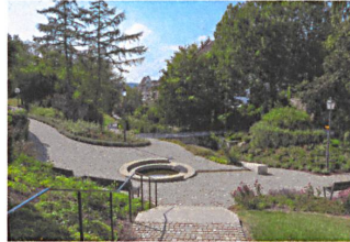
Hochwasserschutz und Revitalisierung Stadtbach, Bischofszell TG Oeplan, Balgach; Wälli Ingenieure, Arbon
