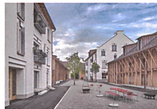
Wohnsiedlung Orenberg, Ossingen ZH BDE Architekten, Winterthur
