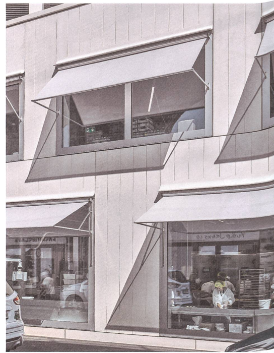
Über den grossen Fenstern biegen sich die dünnen Faserbetonplatten.
