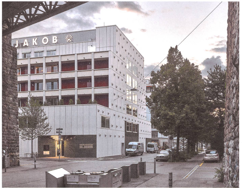
Vom Beton über farbige Keramik bis zur gestrichenen Aussendämmung: Das Gewerbehaus im Zürcher Kreis 5 vereint die unterschiedlichen Welten von Industriebau und Palazzo.
