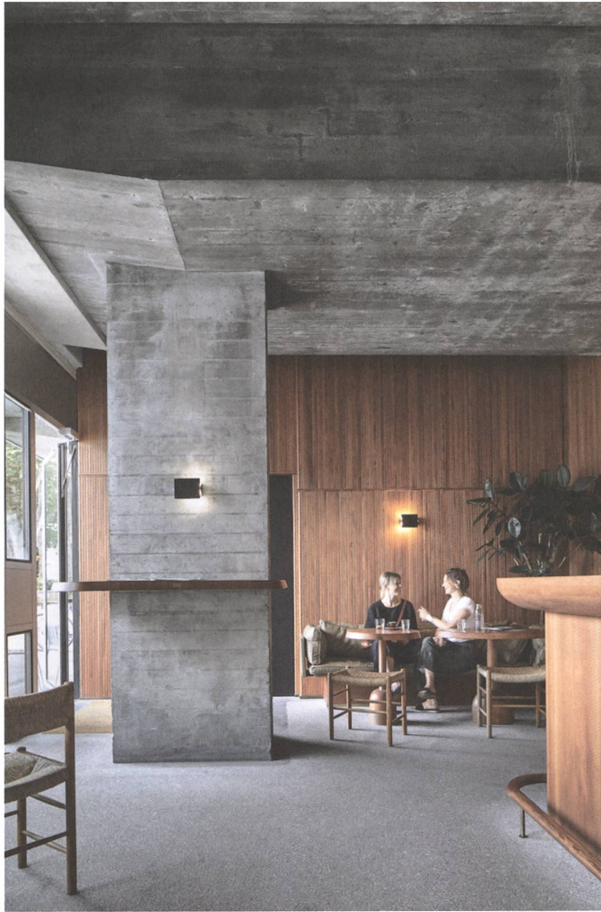
In der Bar Campo umarmen sich Beton und Holz. Die Ablage aus Douglasie schmiegt sich an die Betonsäule, das Holztafer verbindet Boden und Decke aus Beton.
