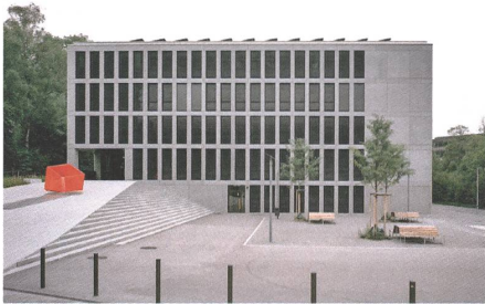
Von aussen ist die Schule ein kompaktes, streng gerastertes Volumen.
