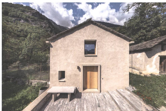
Am Fusse eines grossen Kastanienhains ersetzt der Neubau ein baufälliges Dörrhäuschen. Foto: Raymond Meier
