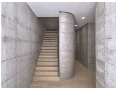
Der Beton im Treppenhaus fängt die Zufahrt zum Nachbarhaus ab.
