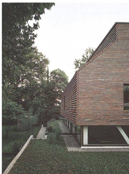
Halb eingegraben sitzt das Atelier auf dem Grundstück.
