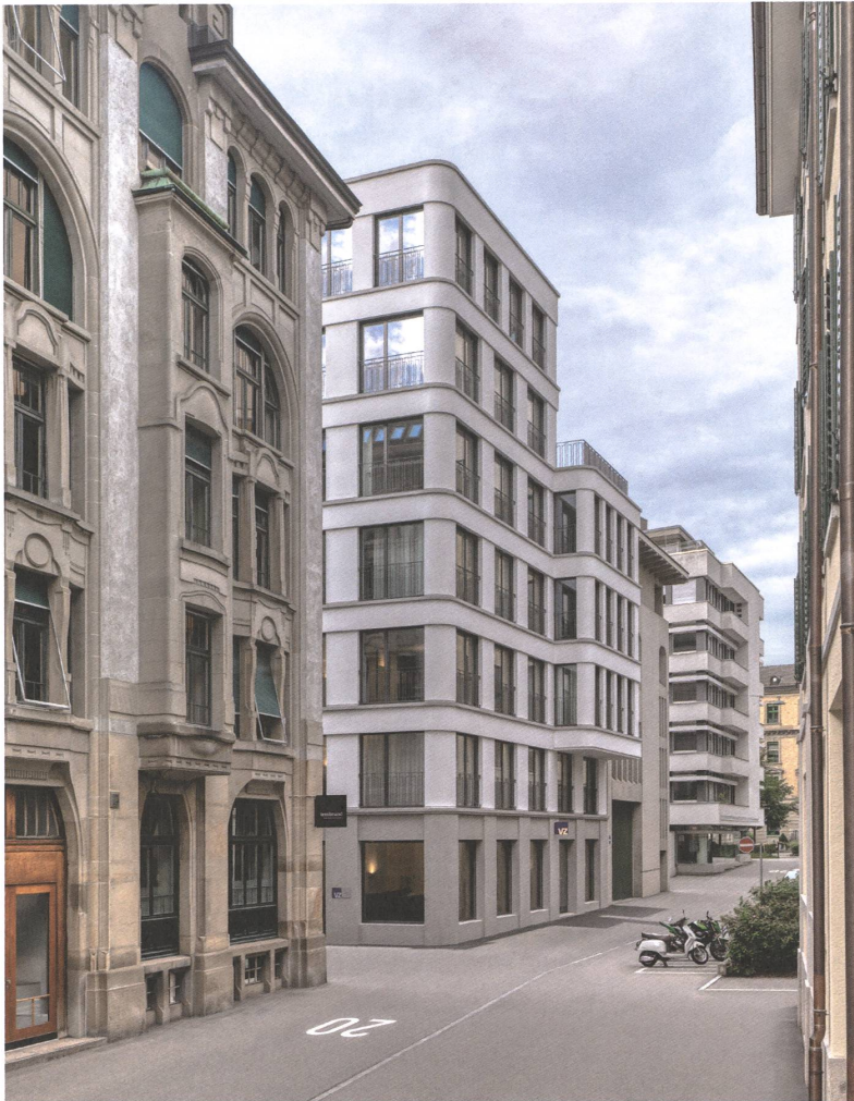
Vermittelt zwischen Jugendstil und 1970er-Jahren: das neue Wohn- und Geschäftshaus an der Sonnengartenstrasse in St. Gallen.
