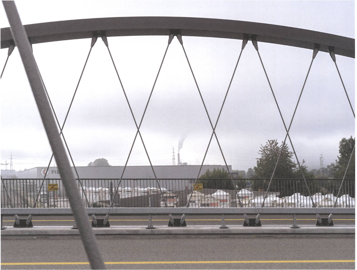
Eine Brücke schlägt den Bogen für die Hauptstrasse über die Eisenbahnlinie Olten-Luzern. Durch ihre Harfe sehen wir die Zwischennutzung eines Fabrikanten von Baustoffen und dann die grosse Kiste von Fiege – einer Logistikfirma, die die Standortgunst des Autobahnkreuzes nutzt. Im Hintergrund raucht die Kehrichtverbrennung.
