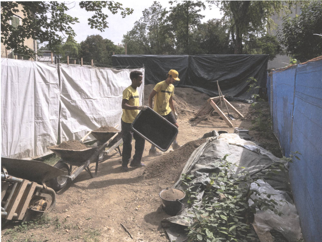
Rund 170 Kubikmeter Aushub wurden auf der Baustelle der Schulhauserweiterung im Geisendorf-Park in Gené für die Ziegelproduktion aufbereitet. Fotos Baustelle: Nicole Zermatten / Stadt Gené
