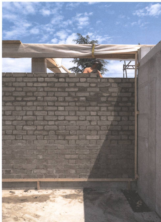
Mit rund sieben Kilo sind die Terrablocs für ihre Grösse recht schwer. Die Maurer hatten trotzdem Freude am geschlossenen Materialkreislauf.
