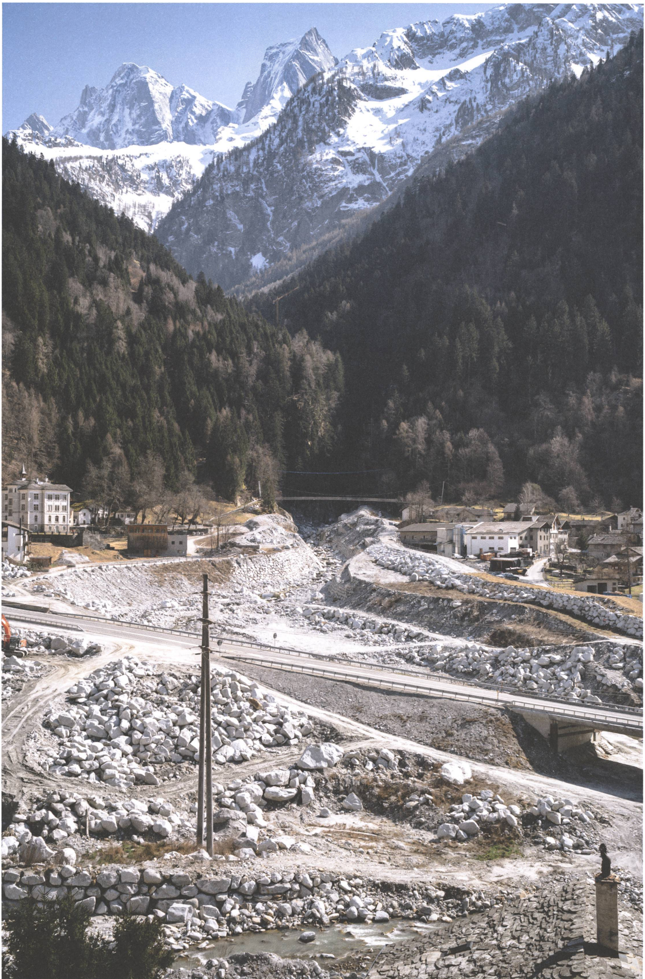
Drei Millionen Kubikmeter lösten sich vom Piz Cengalo und stürzten ins Tal. Nun werden die Dämme der Bondasca erhöht und drei neue Brücken gebaut.
