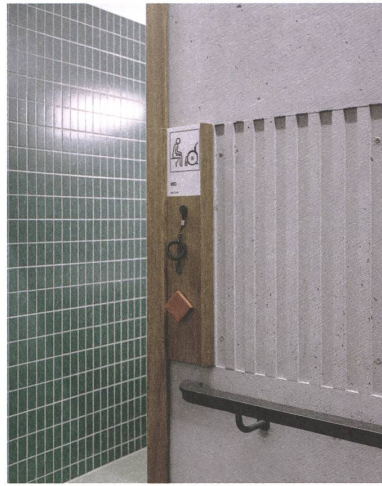
Senkrecht in Beton und Fuge – der erste Stock.
