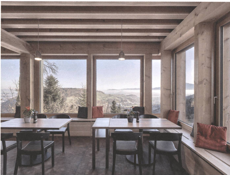
Die Innenständer und Balken des Restaurants tragen eine konventionelle Balkendecke.
