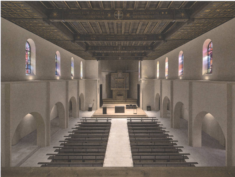
Lisenen und ein hohes Sims gliedern die Längswände der Kirche St. Franz Xaver in Münchenstein. Das sorgt – gemeinsam mit weiteren plastischen Ausgestaltungen und geometrischen Unterteilungen – für eine klare Akustik.
