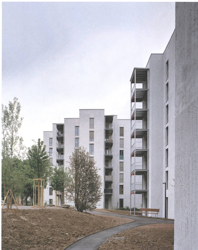
Siedlung Helen Keller in Zürich: Besser kann man kleine, günstige und immer gleiche Alterswohnungen nicht bauen.
