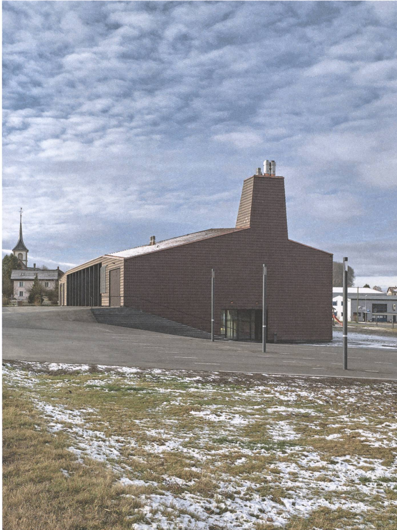
Ein Schuppenkleid aus braunen Dachziegeln verortet die Multifunktionshalle im Freiburger Strassendorf Léchelles. Foto: Roland Bernath
