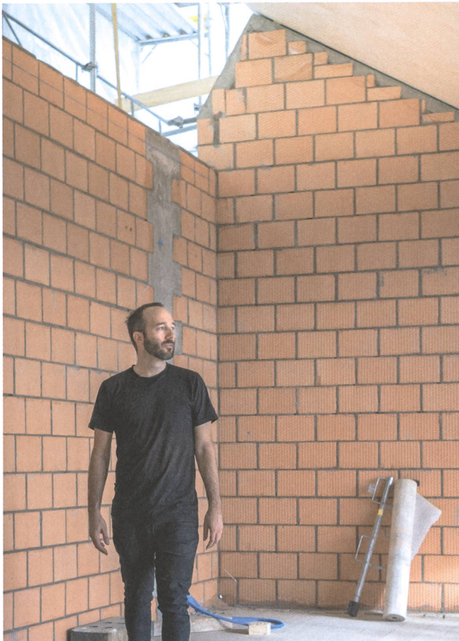
Der Zürcher Architekt Stefan Wülser auf seiner Baustelle in Bassersdorf. Foto: Monika Truong
