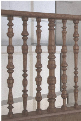
Der Klon und die Skizze: Die Putzfassade wurde in Holz nachgebaut, die Ge- länderstangen im Foyer nach historischem Muster ruppig CNC-gefräst. Fotos: Herzog & de Meuron
