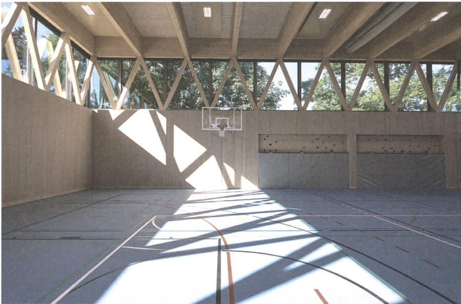
Helles Holz prägt das Innere – auch in der Turnhalle, wo die V-förmigen Stützen ein Blickfang sind.
