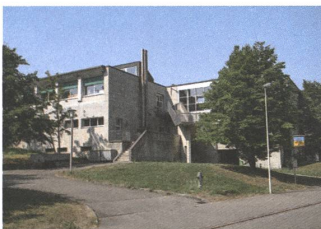
Schulhaus Steinboden, Eglisau: Altbau. Foto: Kantonale Denkmalpflege
