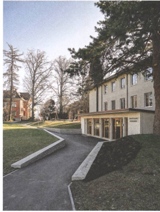
Der neue Anbau für die Tagesbetreuung fügt sich ins Ensemble ein.
