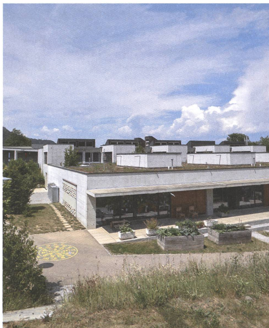
Der Neubau schmiegt sich an den Altbau. Foto: Giuseppe Micciché
